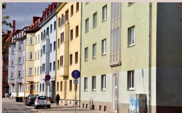
Im Forschungsprojekt wird u. a. die sommerliche Temperaturentwicklung bei unverschatteten Gebäuden und ...
