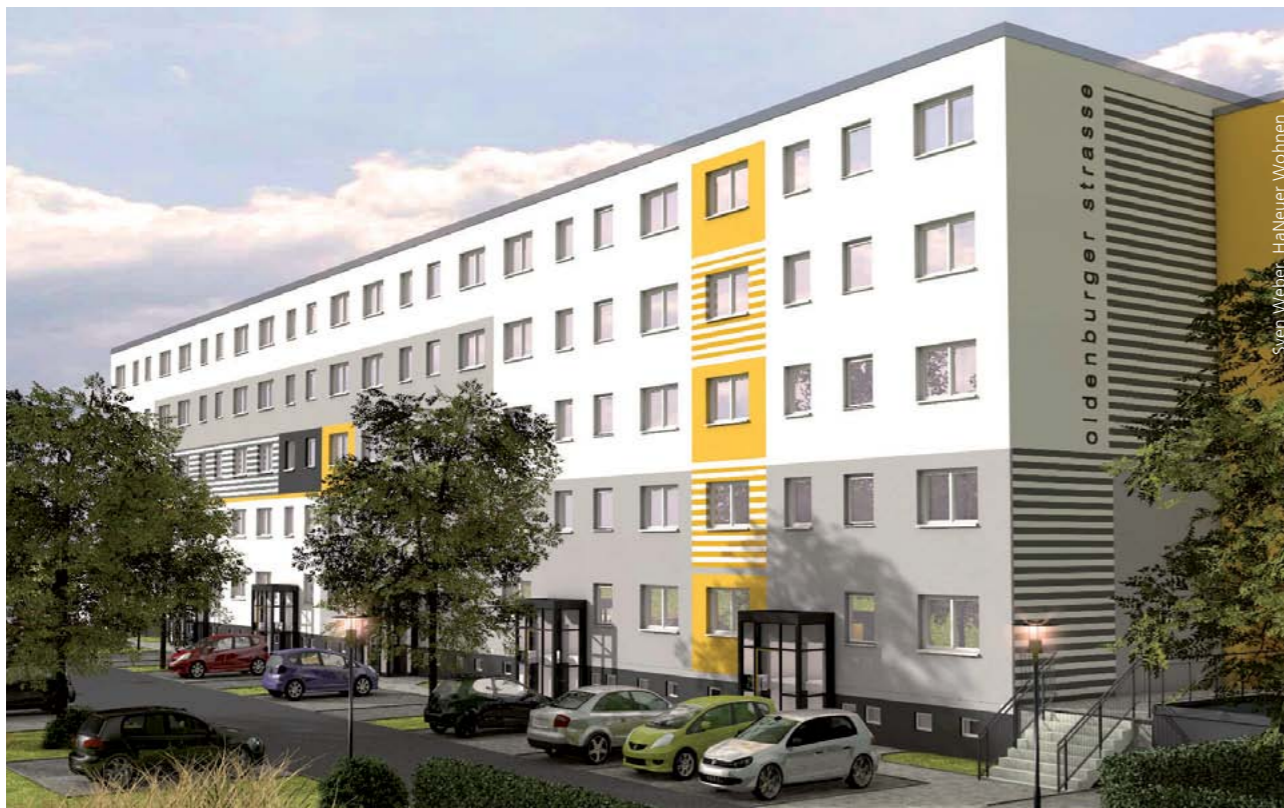
Die Oldenburgstraße 1–11 mit 60 Wohnungen wird gegenwärtig grundhaft saniert. Später sollen hier Programme zu Smart-Home, Vitaldaten und Patientenversorgung angeboten werden.
