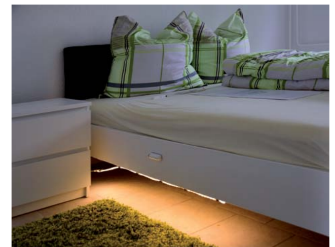
Sturzprävention: Wer zu nächtlicher Stunde beim Toilettengang den Partner nicht wecken möchte, schaltet per Bewegungsmelder die Lichtleiste unterhalb des Bettes ein und senkt so das Risiko zu stürzen.
